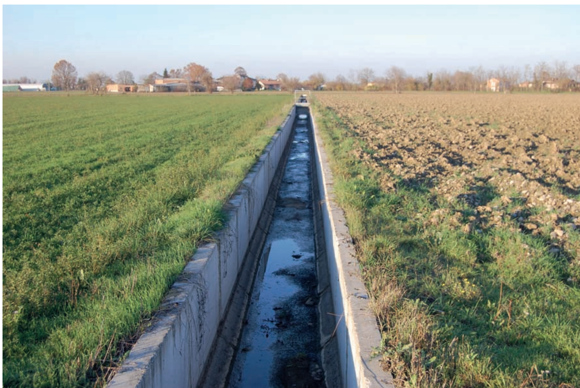
Foto n°5: Particolare del tratto di rio Gragnano, che delimita il comparto verso ovest, recentemente impermeabilizzato
